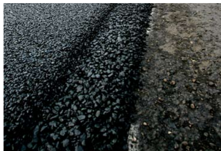
Het aanbrengen van een tweelaags ZOAB wegdek als bronmaatregel om het wegverkeerslawaai te doen verminderen. Foto Dolph Cantrijn
