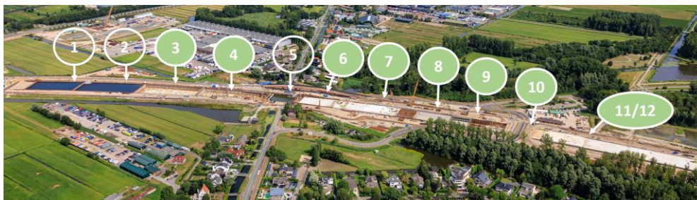
De bouw van het noordelijk deel van de tunnel vanuit de lucht. De vloeren in de bouwkuipen aangegeven in groen zijn al gestort.
