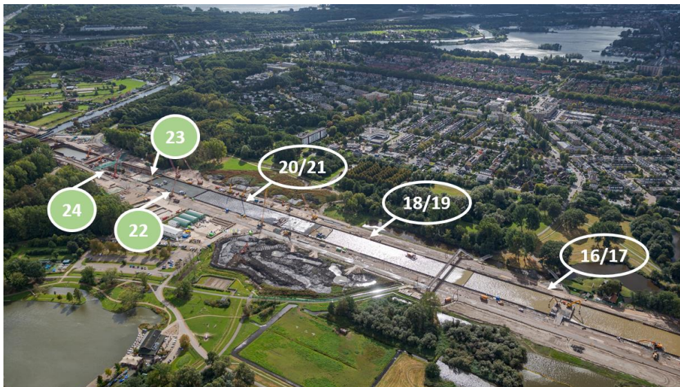
Overzicht bouwkuipnummers zuidelijk deel tunnel. De tunnelvloeren in de bouwkuipen 22/23/24 (in groen) op dit overzicht zijn reeds gestort. Bouwkuip 20/21 gebeurt op 7/8/9 februari.
