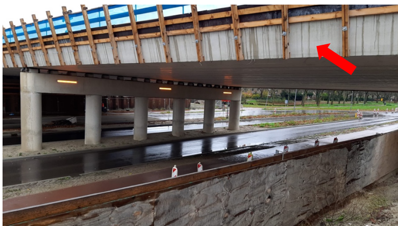
Rode pijl: hier worden straks de randelementen op gemonteerd
