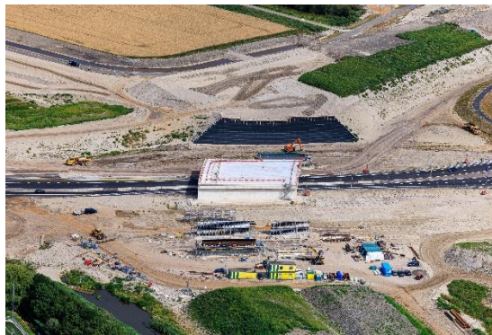
Het Ankie Verbeek-Ohrlaan viaduct in aanbouw. Medio juli is de N209 verlegd onder het eerste deel van het nieuwe viaduct door.
